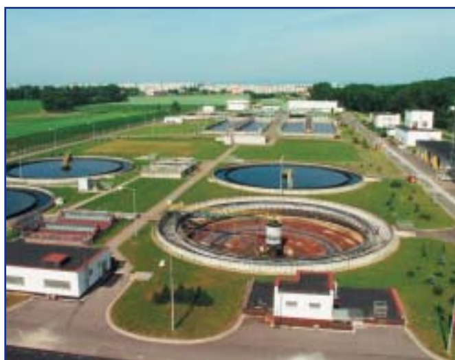
Čistírna odpadních vod v Hradci Králové.
