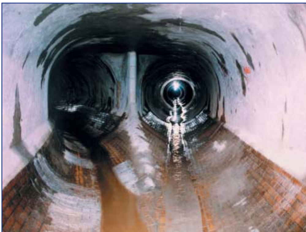
Zhlaví kanalizačních stok, Hradec Králové.
