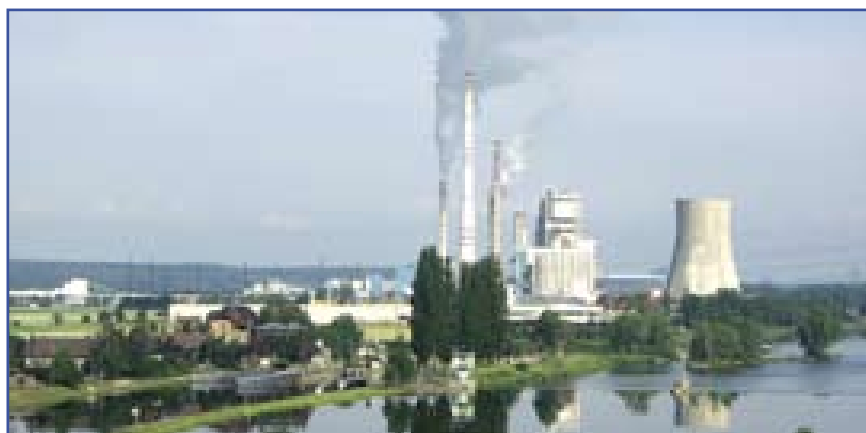
Labe river, Mělník - power station
