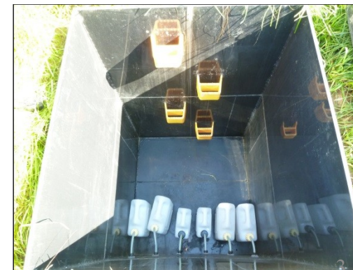
Pohled do Lyzimetrické šachty Hradec n. Svit.
