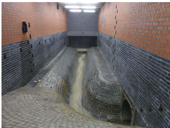
Odlehčovací komora OK_1c v Maďarské ulici. Foto: PVS a.s.
