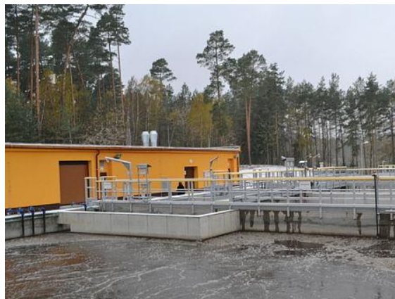
ČOV Hradčany. Foto: Syner s.r.o
