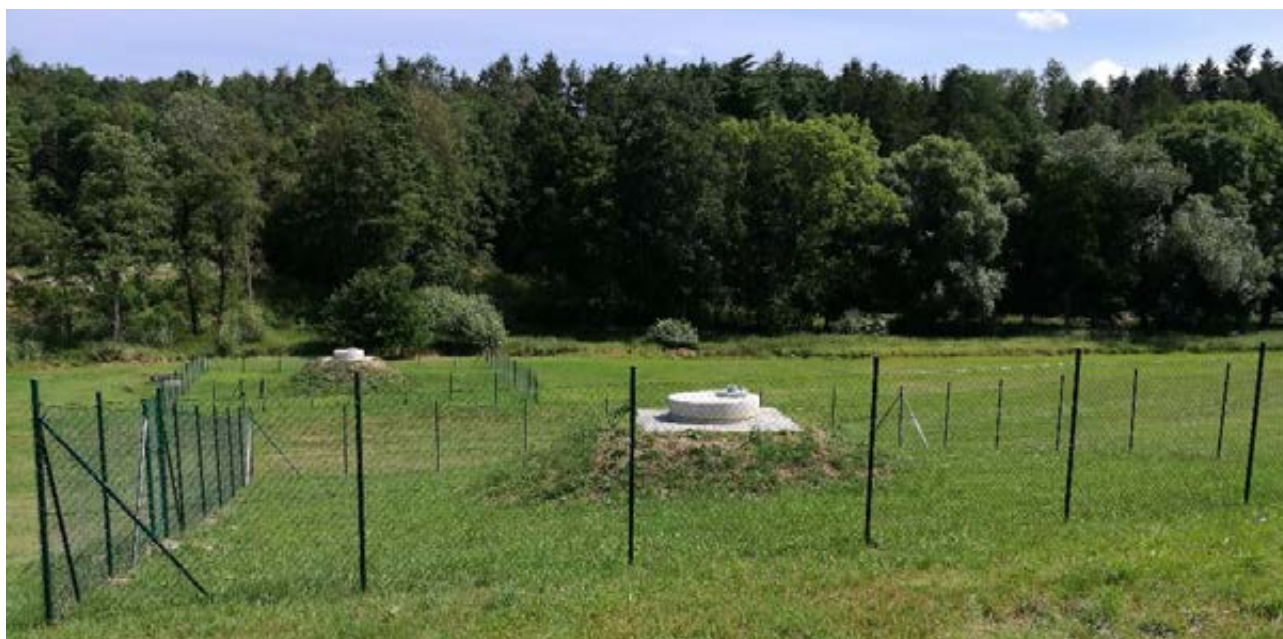
Osvračín - veřejný vodovod - financováno s podporou MZe ve výši 12,029 mil. Kč.
