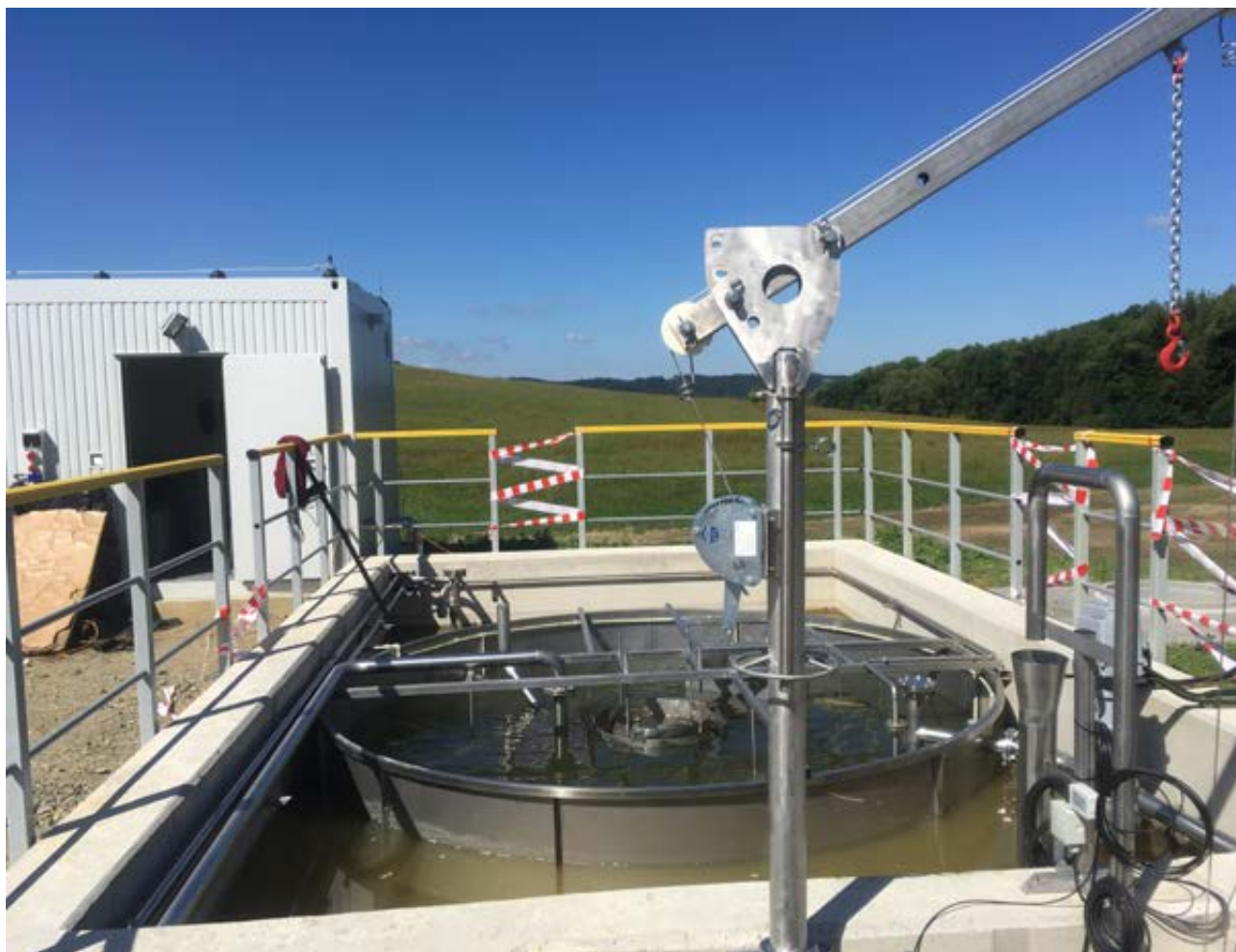
Jistebnice - Božejovice - kanalizace a ČOV - financováno s podporou MZe ve výši 6,345 mil. Kč
