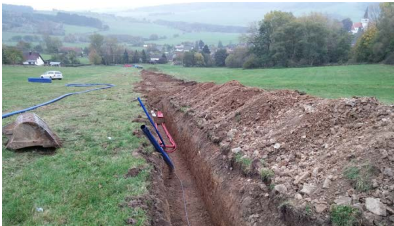
Loučim-veřejný vodovod-II. etapa - financováno s podporou MZe ve výši 2,120 mil. Kč.
