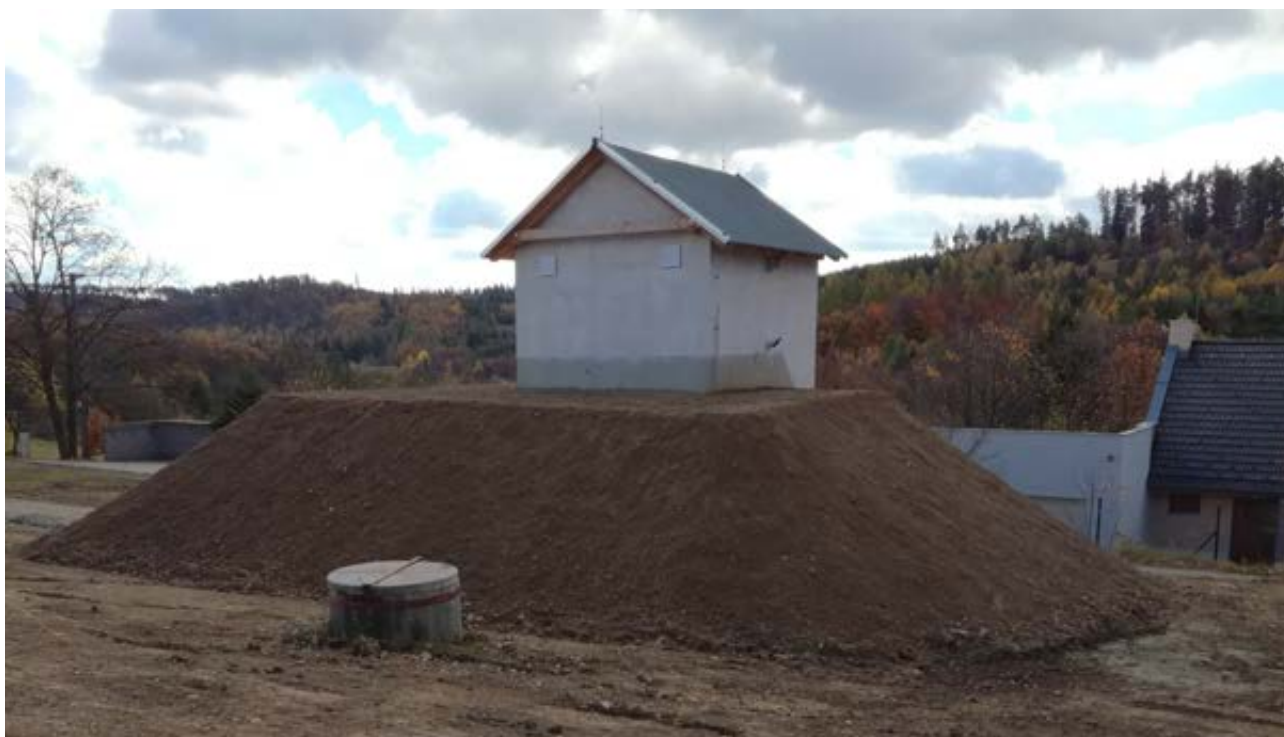
Vodovod Prostějovičky - financováno s podporou MZe ve výši 7,523 mil. Kč.
