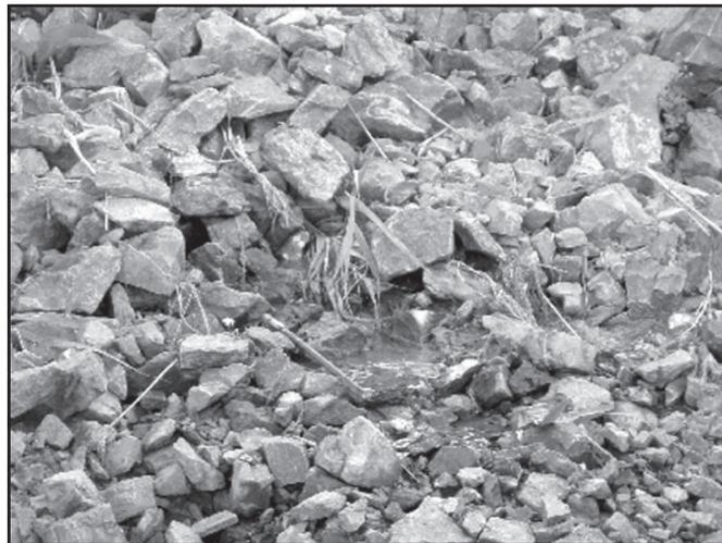
**Obr. 7** Výron vody pod skluzem korunového přelivu opravené hráze nádrže R5
