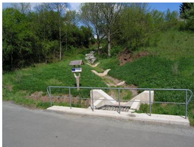
Svodný průleh, Bačov, okr. Blansko
