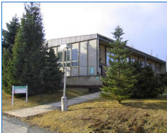
Budova pracoviště SRS v areálu VÚRV Praha - Ruzyně
