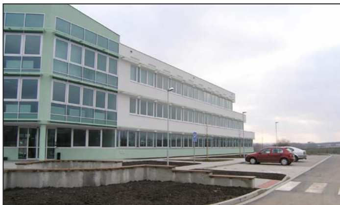
Křídlo budovy SRS v Praze s DL v přízemí (2009)
