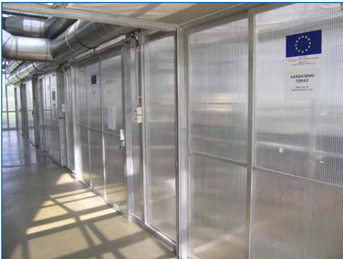
Spojovací chodba karanténního skleníku v Olomouci
