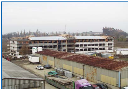
Hrubá stavba budovy SRS v Olomouci (2003)
