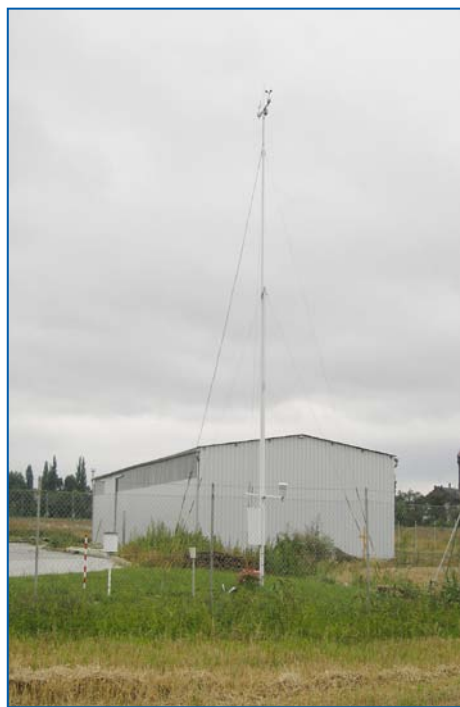
Automatická meteostanice ČHMÚ, na pozadí montovaná hala (2005)
