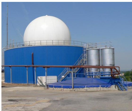
Obr. 4 Textilní dvouplášťový plynomej fy SATTLER (Rakousko) (objem 100 – 2150 m 3 , polyesterová tkanina + PVC, nízkotlaký 0,5 – 2,5 kPa, životnost 20 – 30 let) – firmu SATTLER zastupuje v ČR K & H Kinetic a.s.
