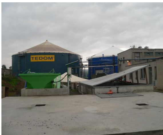
Obr. 3 Textilní dvouplášťový nasedlaný plynomej, obvykle polyesterová tkanina + PVC, nízkotlaký 0,5 – 2,5 kPa, životnost 20 – 30 let nabízí řada firem, v ČR např. Tomášek SERVIS s.r.o.
